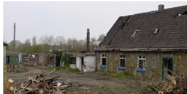
Abbruchvorhaben: viele Teilleistungen sind zu kalkulieren!
